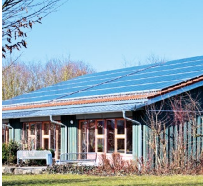
Foto: Eine unserer zahlreichen Photovoltaik-Anlagen auf dem Dach der ev. Heilerziehungspflege-Schule in Schwäbisch Hall.
